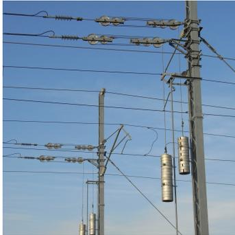
Le passage du pantographe, et la force de soulèvement verticale qu'il exerce sur la caténaire, la fait osciller selon une amplitude pouvant atteindre 30 cm à très grande vitesse. En pratique la tension mécanique des caténares est assurée par des tendeurs munis de contrepoids de 1000 kg (cylindre sur la photo ci contre).
